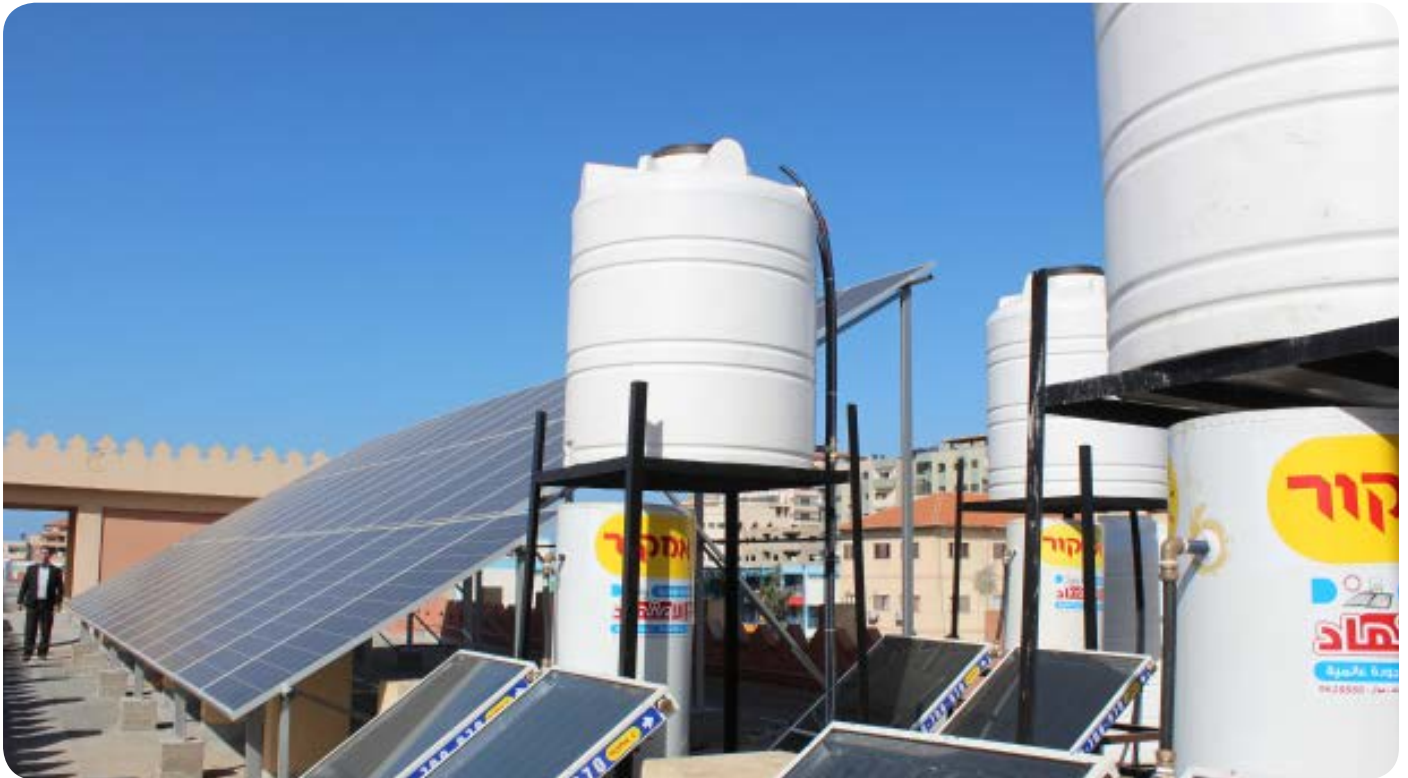
( براميل مياه وحمامات شمسية ونظام طاقة شمسية تم تركيبه خلال المشروع )
